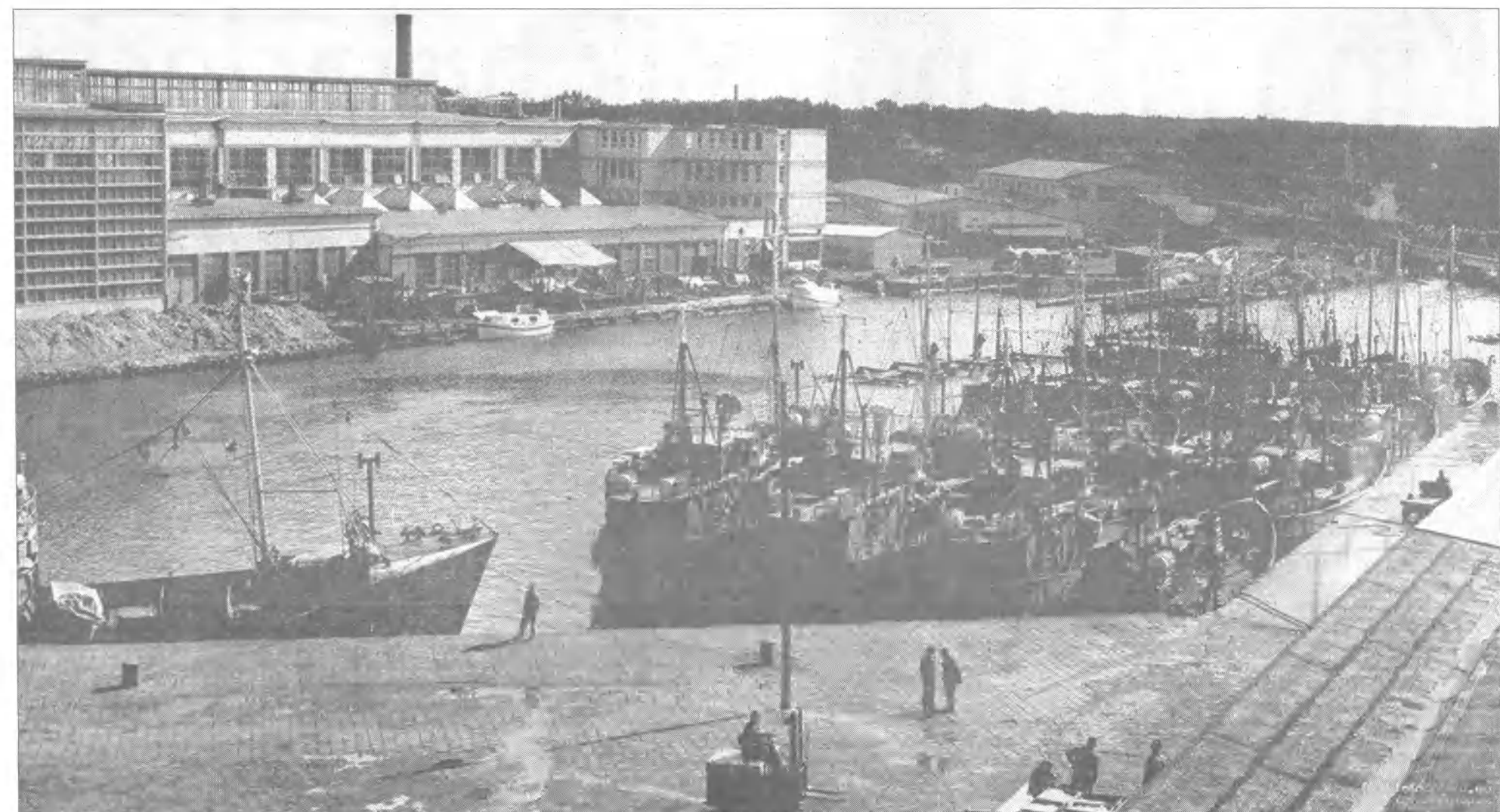
Widok na halę kadłubową w Ustce z początku lat 70. Część biurowa jeszcze w budowie, a przy nabrzeżu widać dwie laminatowe szalupy ratunkowe na tankowce. Na pierwszym planie flotyła kutrów rybackich Korabia.
