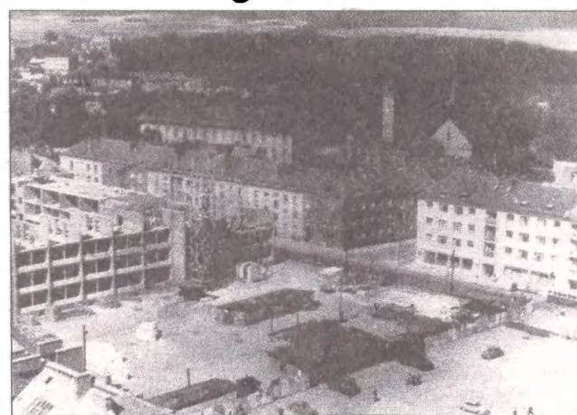
Ratusz w trakcie budowy.
