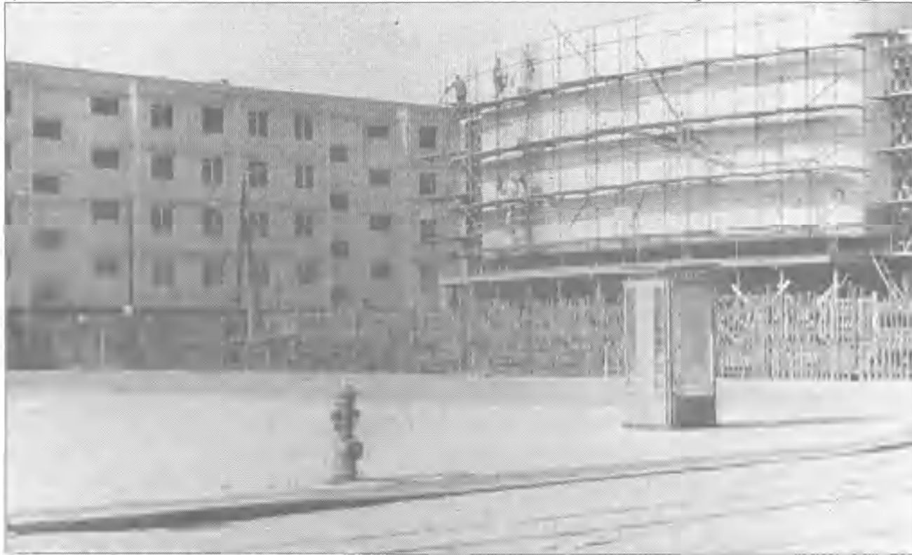
Prace wykończeniowe kina Milenium na ówczesnym placu Armii Czerwonej.
