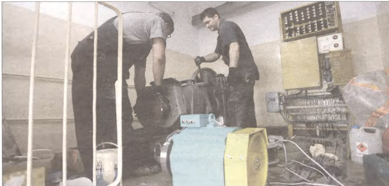
Remont szybu i wymiana windy w klatce C bloku przy ul. Batorego 23.
