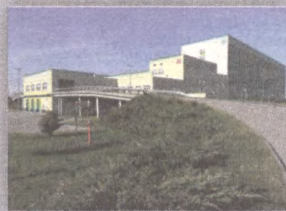
Budowa Wojewódzkiego Szpitala Specjalistycznego w Słupsku.
