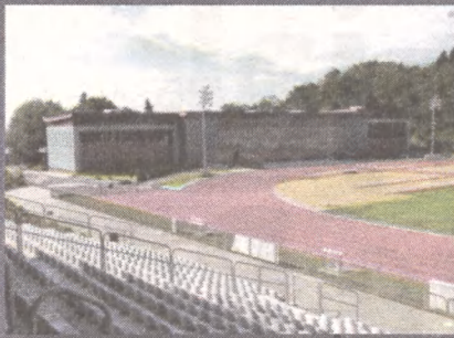
Budowa Centrum Lekkoatletycznego, ul. Madalińskiego
