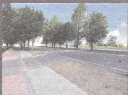
Przebudowa ulic Poniatowskiego i Grunwaldzkiej
