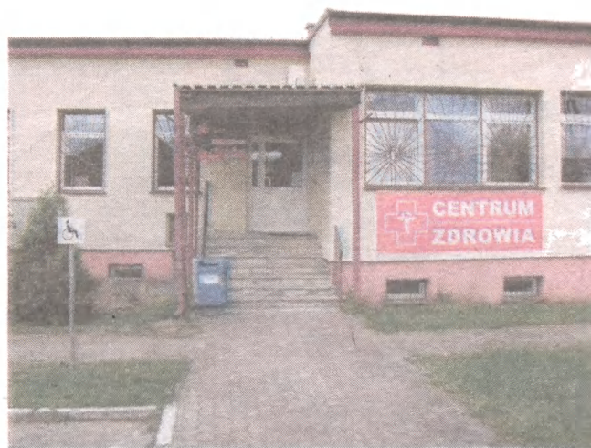
► Przychodnia niedawno przeszła kompleksowy remont. Teraz pacjenci są zadowoleni
