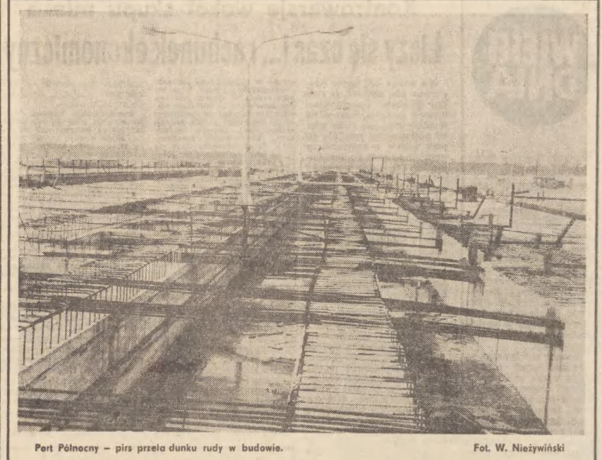
Port Pólcno - pirs przeładunkowy w budowie.
