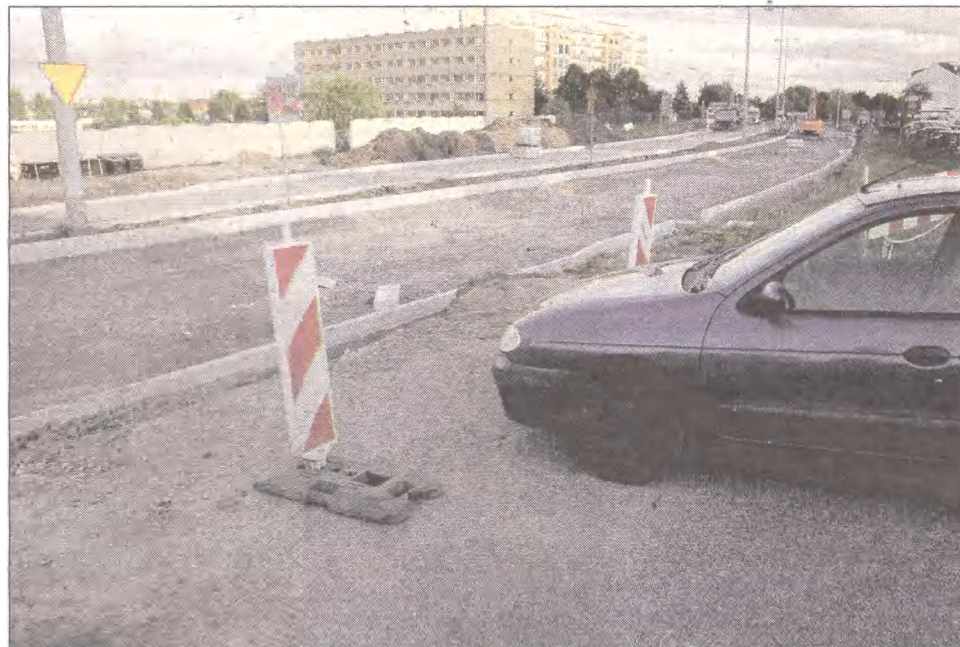
Niewiele jeszcze na to wskazuje, ale po remoncie będzie można przejechać z ul. Sobieskiego w kierunku garaży przy ul. Bogusława X.
