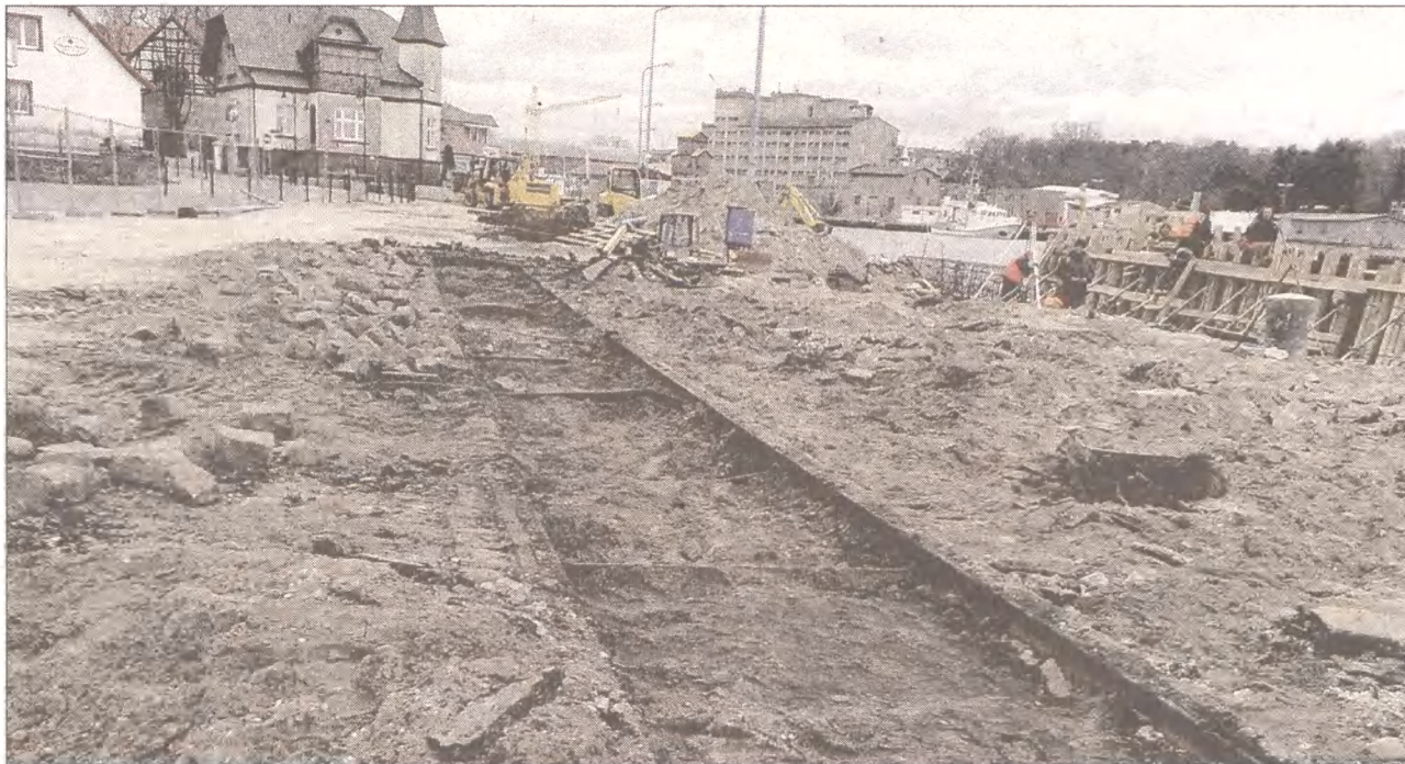
Kiedyś po tych szynach przyjeżdżały pod ustecką latarnię morską pociągi z letnikami.
