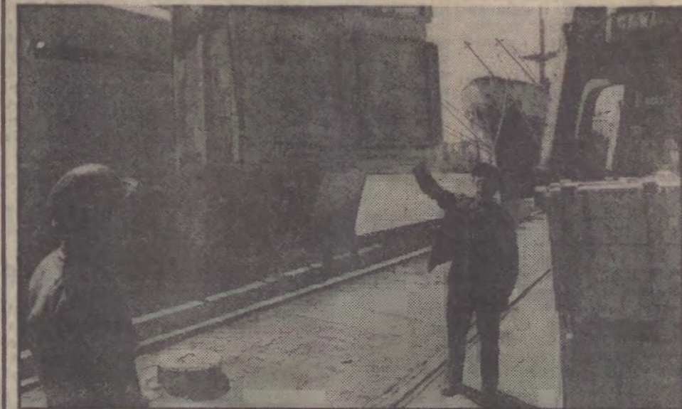
Port gdynski — przeladunek drobnicy.
