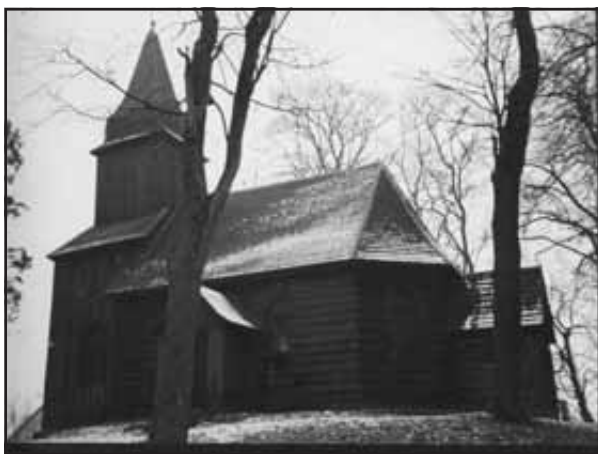
Kościół zbudowany został w latach 1755-1757 przez cieślę Westphala z Bytowa. Jest on drewniany o konstrukcji zrębowej, salowy. Dwukondycyjna wieża posiada konstrukcję słupową. Dach kościoła dwuspadowy pokryty jest gontem. Zakrycia dobudowana została na początku XX wieku. Kościół w przeszłości był kościołem ewangelickim, obecnie pw. Królowej Polski jest kościołem katolickim, filialnym parafii w Ugoszczy.
