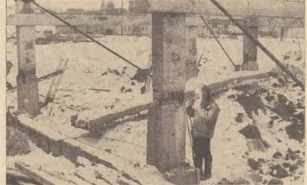
Fragment budowy Szpitala Wojewódzkiego w Elblągu. Fot. J. Folwarczny
