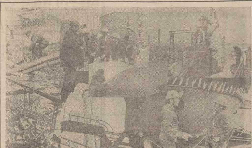
Budowa Huty „Katowice” jest największą inwestycją jaką podjęto w całej historii naszego kraju. Jest realizowana kompleksowo (równocześnie wszystkie wydziały — 1500 obiektów). Równoległe z budową huty rozwija się budownictwo mieszkaniowe dla przyszłej załogi, trwa modernizacja i rozbudowa dróg szybkiego ruchu, sieci handlowej i usługowej. Zakończenie pierwszego etapu budowy nastąpi już w IV kwartale br. W roku 1978 opuści Huta „Katowice” 4,5 mln ton stali i wysokiej klasy wyrobów hutniczych. W II etapie budowy huta będzie produkowała 9-10 mln ton stali, co postawi ją w rzędzie największych zakładów tego typu
