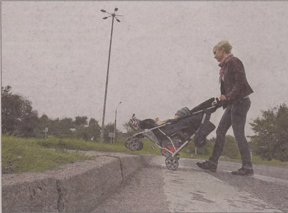
Zbyt wysokie krawężniki to bariera dla rodziców z wózkami.
