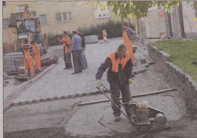
Nowa nawierzchnia przy ul. Kotarbińskiego.
