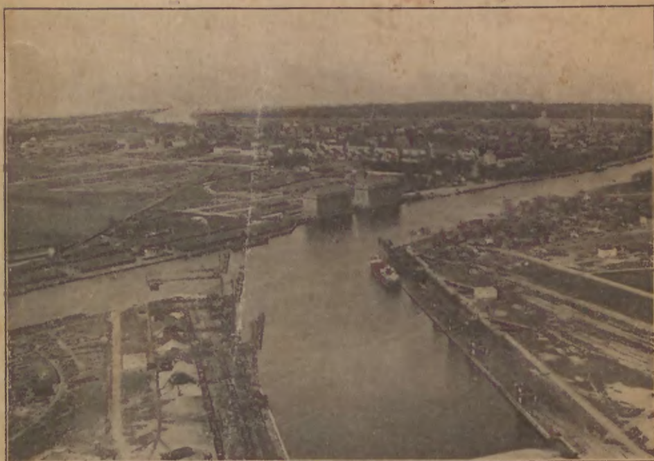
Basen dla towarów masowych w Wisłoujściu. Naprzeciw basenu śpichlerze o pojemności 28000 ton.
