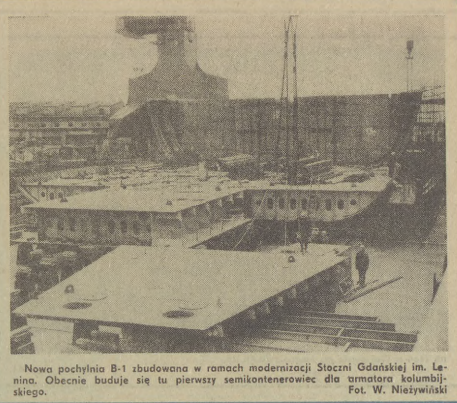
Nowa pochylnia B-1 zbudowana w ramach modernizacji Stoczni Gdańskiej im. Lenina. Obecnie buduje się tu pierwszy semikontenerowiec dla armatora kolumbijskiego. Fot. W. Nieżywiński
