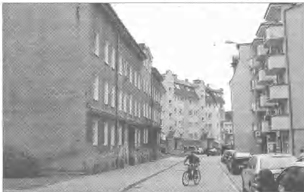
Mieszkańcy starszych budynków przy ulicy Drewnianej twierdzą, że ich kamienice wymagają remontu. Podobnych problemów nie mają ich sąsiedzi mieszkający w nowych blokach.
