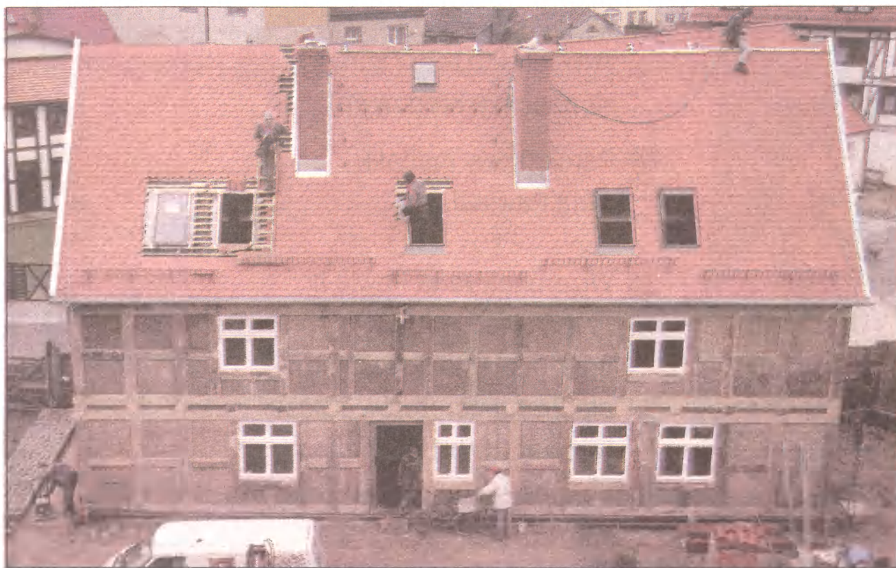
Prace przy budowie Bałtyckiego Centrum Kultury w Ustce. Ściany budynku wykonano z pruskiego muru, tak jak robiło się to przed dwustu laty. Fot. LC
