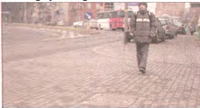
Piesi i kierowcy samochodów nie muszą się już bać zapadniętej studzienki telekomunikacyjnej przy ul. Kilińskiego.
