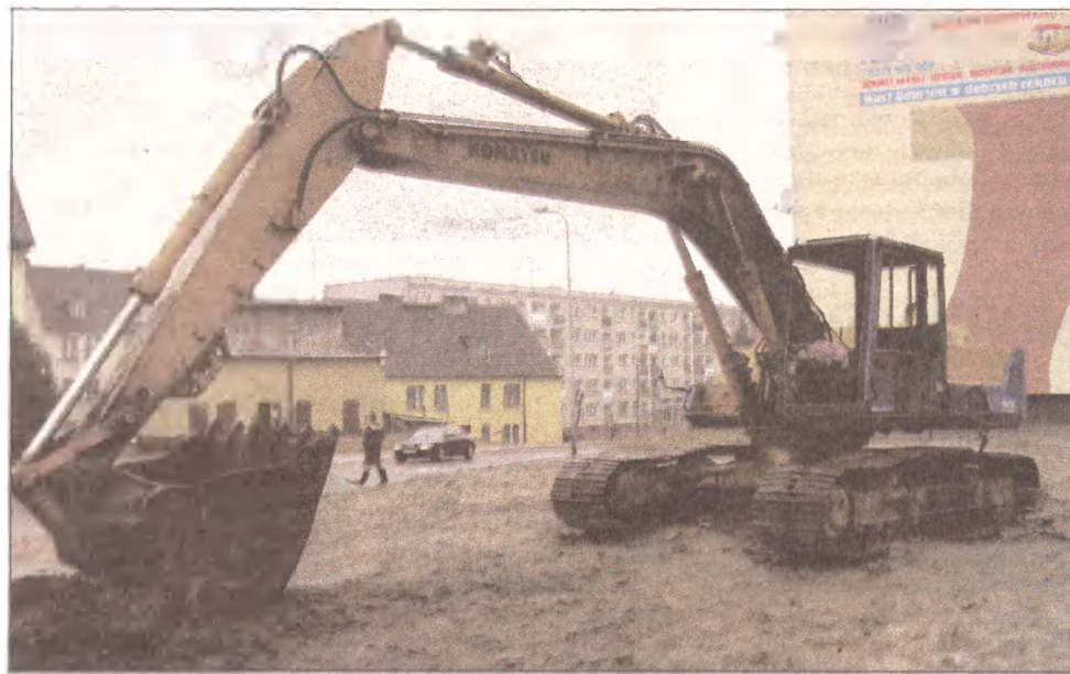
Porzucona koparka przy ulicy Szewskiej w Miastku przeszkadza mieszkańcom.
