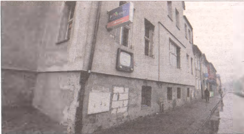
Zniszczone w wyniku pożaru biuro firmy Partner przy ulicy Targowej. Lęborska policja wyznaczyła nagrodę w wysokości dwóch tysięcy złotych za ustalenie sprawcy podpalenia.
