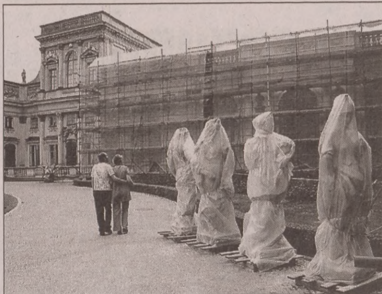
Spacer wśród mumii? - Posagi zabezpieczone przed wpływem czynników atmosferycznych w trakcie remontu pałacu w Wilanowie.
