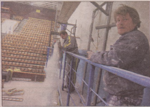
Ostatnie prace w słupskiej Gryfi.
