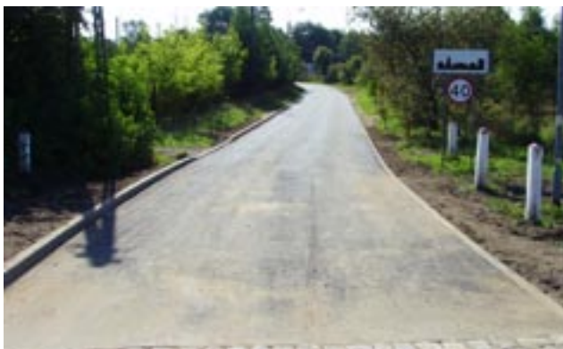
Nowa nawierzchnia ulicy Kolejowej w Widzinie
