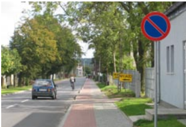
Ulica Wodna w Kobylnicy
