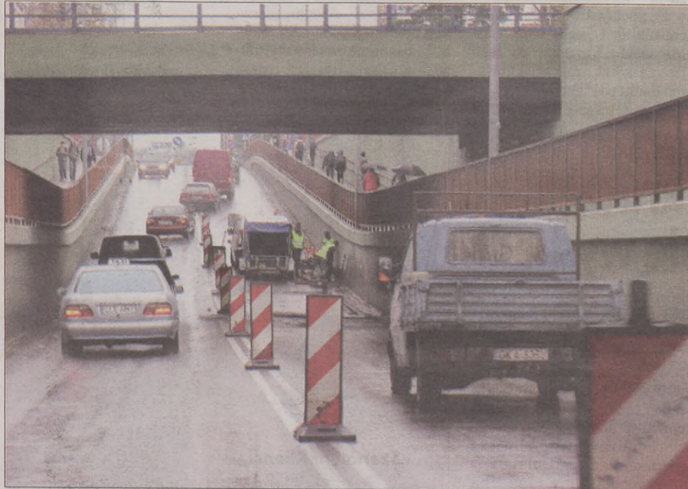
Prace pod tunelem.
