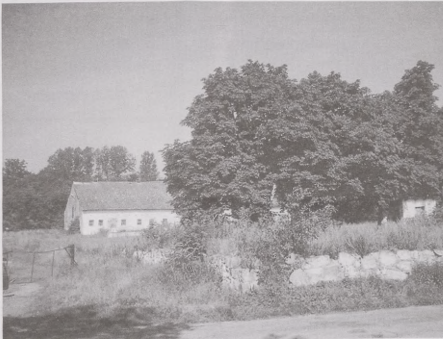
Pozostałość po zabudowaniach folwarcznych
