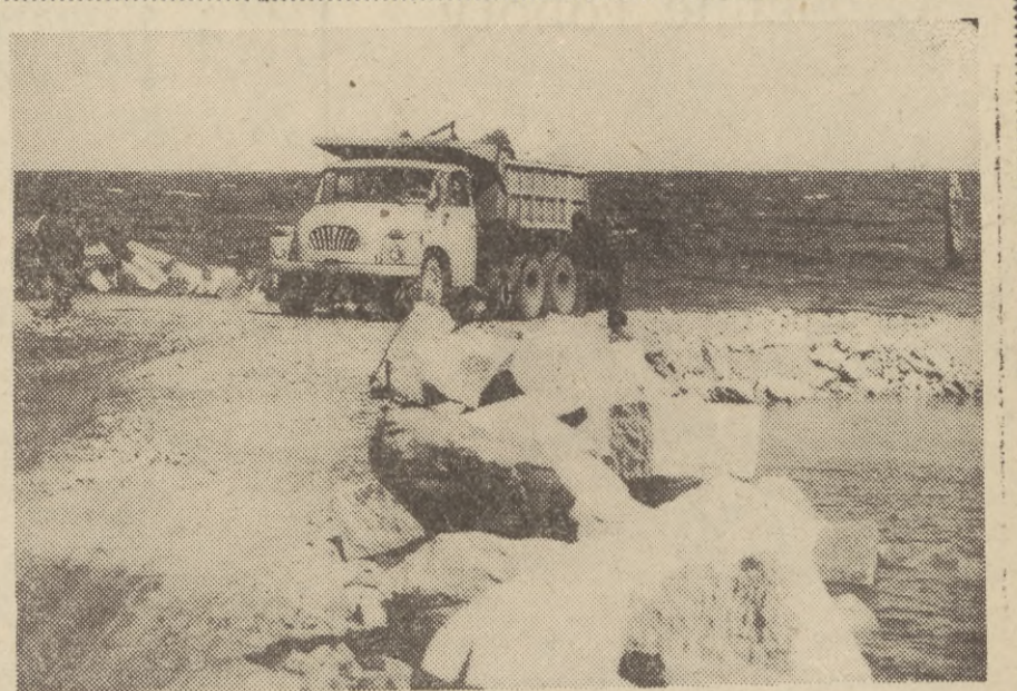
Na terenach budowy portu północnego w porcie gdańskim trwają intensywne prace. Tylko w tym roku przerób inwestycyjny wyniesie 313 mln zł. Obejmuje on prace na zapleczu przy budowie zakładu prefabrykacji skrzyń falochronowych oraz na brzegu morskim, gdzie usypywane są obecnie z kamienia falochrony brzegowe — północny i wschodni. Wykonuje się również prace pogiębiarskie na obronicy przysięgłego portu. Do nowych nabrzeży portu północnego pierwsze statki po węgla przybędą w 1974 r. Na zdjęciu: usypywanie z kamienia falochronów brzegowych. Fot. W. Nieżywiński
