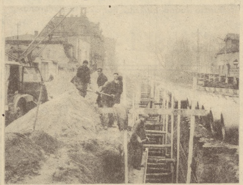
Pracownicy WPRWK w Gdańsku podczas zakładania kolektora ściekowego pod przyszłą drogę na południe Gdańska. Fot. W. Nieżyński
