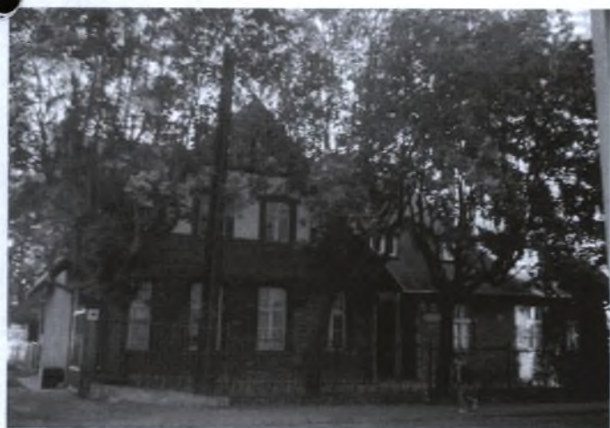
Budynek przy ul. Lubawskiej 4 stanowiący integralną część Szkoły Podstawowej nr 10 fot. J. Śliwińska
