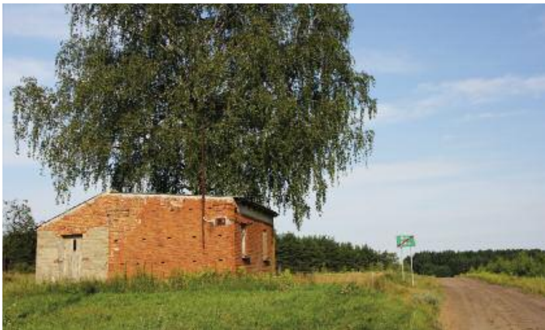
Fot. 2. Tu zaczyna się stary trakt wiodący z Huty do Kosobud, krótszy niż wygodne asfaltowe szosy, ale przeznaczony z powodu swojej piaszczystości tylko dla rowerzystów-ekstremalistów.
