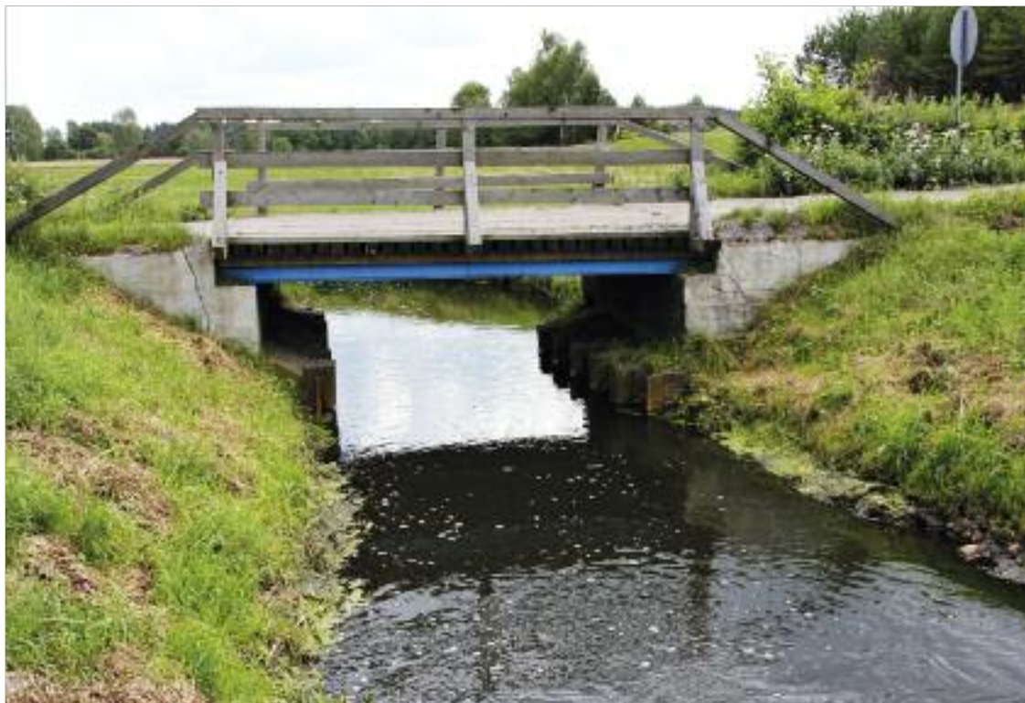
3. Most na Niechwaszcy na drodze z Chłopowów do Czarniża i Olszyn. Fot. Zbigniew Gierszewski, 2012.
