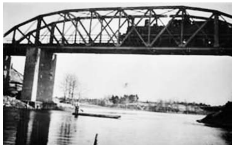
Most kolejowy do 1939 roku
