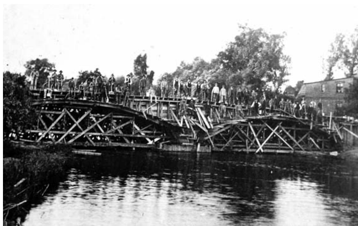
Budowa mostu betonowego w 1911 r.
