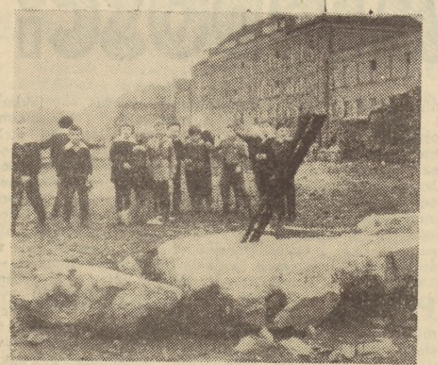
Wiosną 1965 roku w czasie układania gazociągu rozkopano boisko szkoły nr 37 przy ul. Ogara...
