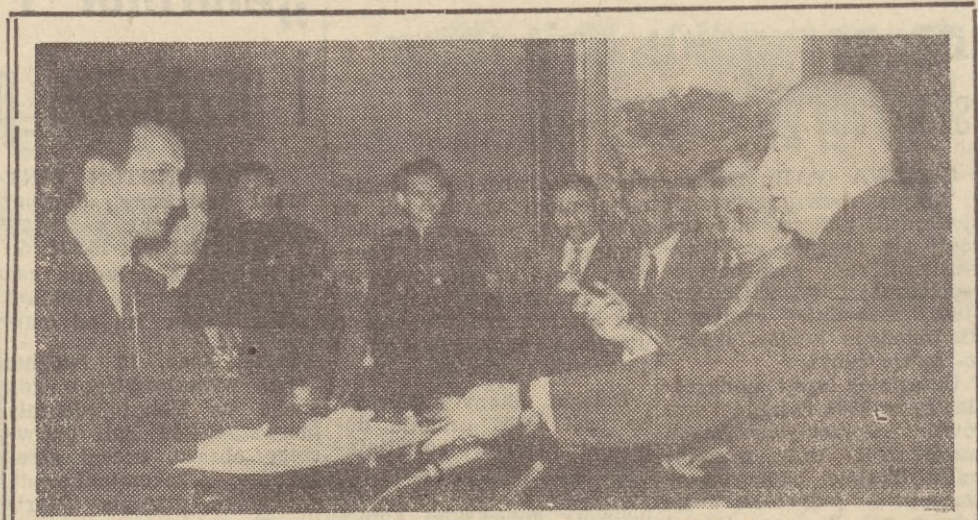
W dniu 14 bm. w przeddzień oficjalnego zakończenia I etapu budowy elektrowni „Turów” przez Radę Ministrów Józef Cyranekiewicz przyjął kilkunastoosobową delegację budowniczych kombinatu turawskiego. W spotkaniu uczestniczyli minister budownictwa i przemysłu materiałów budowlanych Marian Olewiński i wiceminister Stefan Fariaszewski oraz wiceminister górnictwa i energetyki Karol Fabris.
