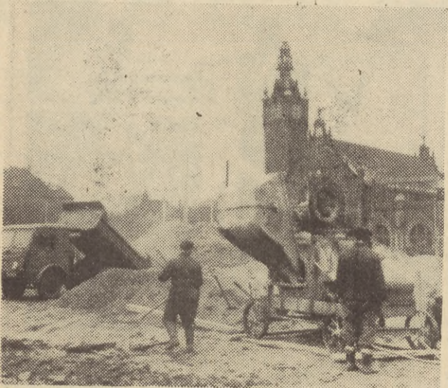
Za tydzień, najpóźniej za 10 dni, część wiaduktu od strony hotelu „Orbis” na przeciw dworca głównego w Gdańsku będzie wykonana w stanie surowym...
