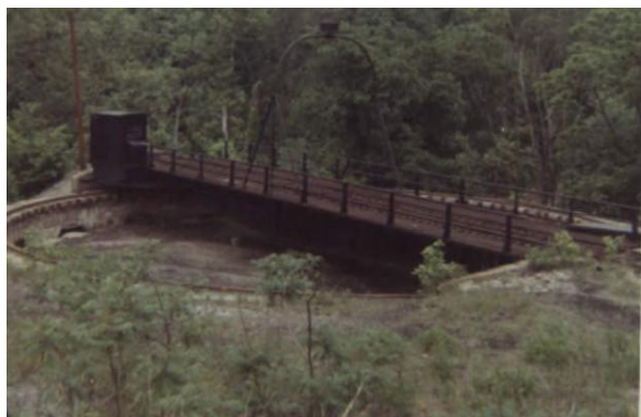
Miejsce, w którym pracował Andrzej przy naprawach wagonów. Zdjęcie z roku 1971 r.
