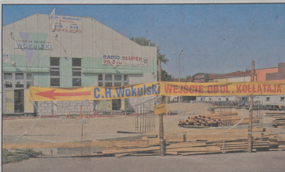
Zaplecze „Wokulskiego” przerodziło się w wielki plac budowy.
