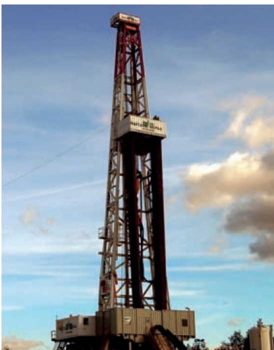
Na wzgórzu przy drodze z Lewina na Staniszewo stoi już 45-metrowa wieża wiertnicza.
