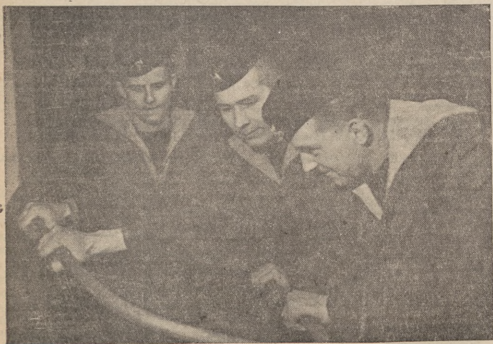
Kolana rur należy wyginać płynnie, aby zwiększyć szybkość obiegu wody słodkiej — do- brze o tym pamięta st. mar. Chojnacki, mar. Skarupa i mar. Brzostowski.
