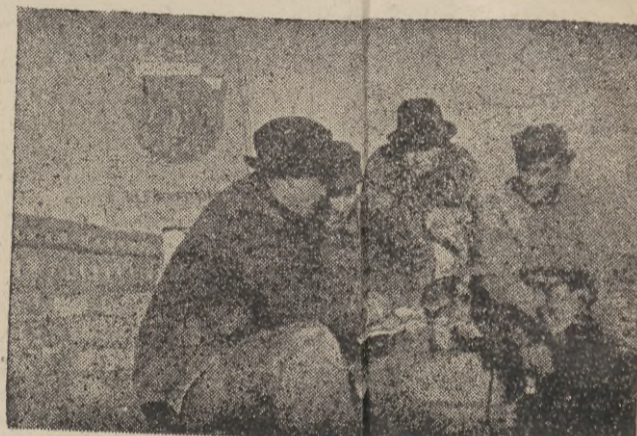
Budowa nowych bloków mieszkalnych dla robotników Stoczni Gdańskiej. Na zdjęciu: Murarze ZMP-owcy z brygady im. Feliksa Dąbrowskiego, wykonujący przy budowie bloków mieszkalnych dla stoczniowców gdańskich 280 proc. normy, amawiają monogram Prac.
