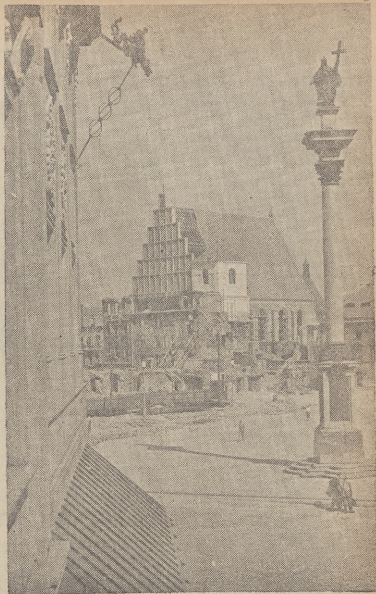
Szybko postępują prace na budowie naszej stolicy. Na zdjęciu: fragment Placu Zamkowego z odbudowaną Katedrą.
