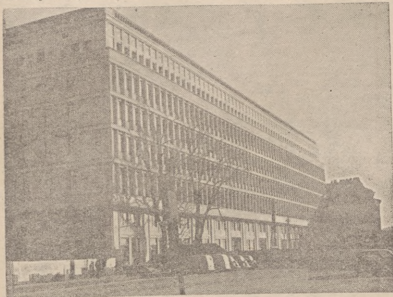
W szybkościowym tempie rośnie socjalistyczna stolica Polski Ludowej — Warszawa. Na zdjęciu nawybudowany dom Polskiej Zjednoczonej Partii Robotniczej.
