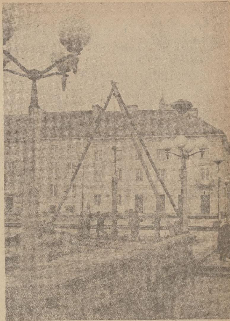
Na trasie przyszłego metra warszawskiego rozpoczęto już roboty przygotowawcze — badania gruntowe. Na zdjęciu: Wieża wiertnicza zainstalowana na Rynku Mariensztackim.
