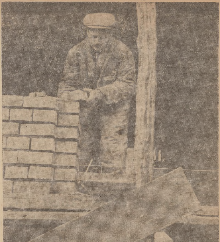
Mimo sezonu zimowego roboty budowlane kontynuowane są bez przerwy. Na zdjęciu: przodownik pracy na budowie osiedla mieszkaniowego na Muranowie — brygadziśta Majchrowski Stanisław, którego zespół wykonuje ponad 200 proc. normy.
