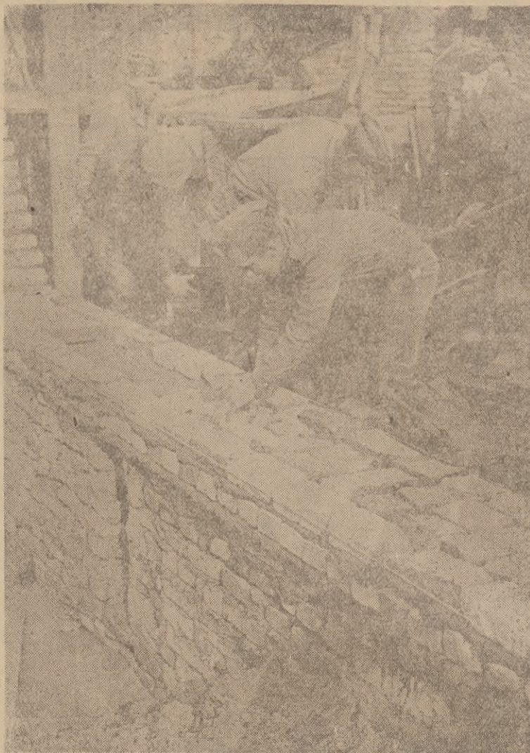
Wysiłkiem całego narodu powstaje nowa socjalistyczna Stolica. Na zdjęciu: fragment budowy MDM.
