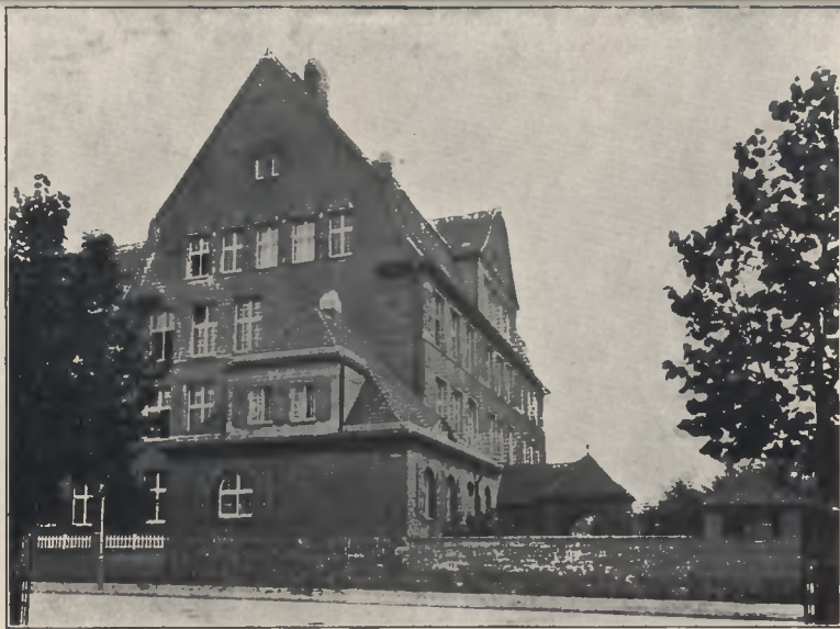
Ansicht der Südostecke.
