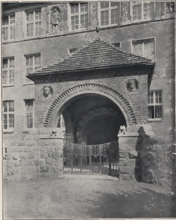
Haupteingang an der Deutschen Straße.
