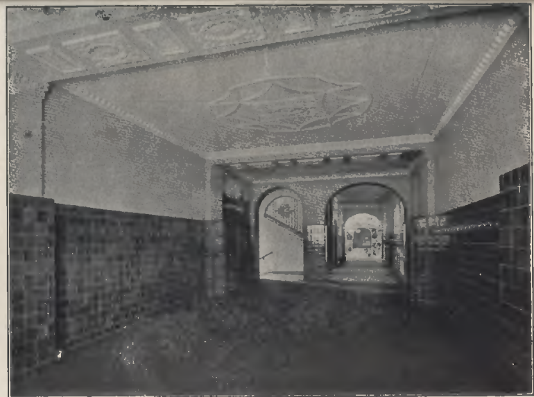
Vorraum der Aula mit Flur und Nebentreppe.
