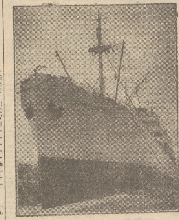
Lśniący świeżą farbą „Fryderyk Chopin” stoi przy nabrzeżu w Gdańskiej Stoczni Remontowej.
