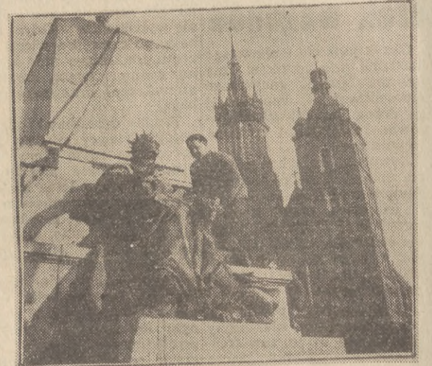
Prace przy montażu pomnika Adama Mickiewicza na Rynku Głównym w Krakowie dobiegają końca. 19.XI. br. nastąpiły próby ustawienia figur na cokole. Figury alegoryczne zostały już ustawione. Obecnie odbywa się ich umocnienie i patynowanie.
