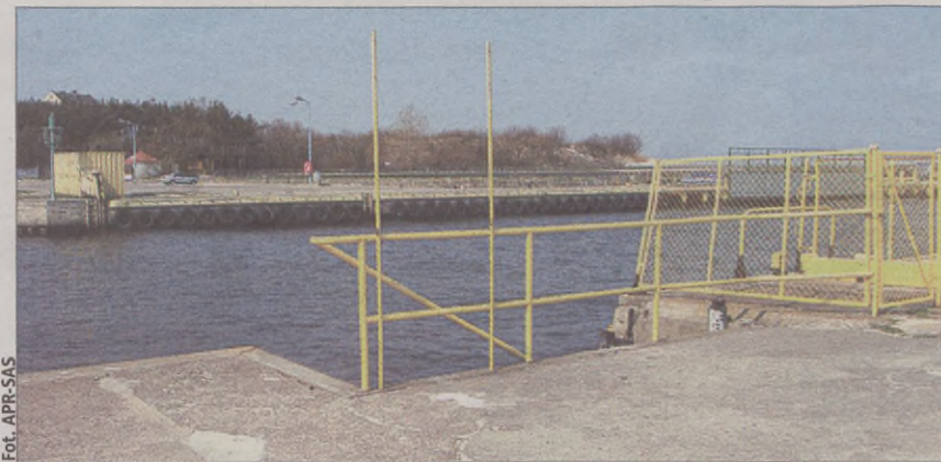
W tym miejscu ma stanąć kładka budowana przez ratusz.
