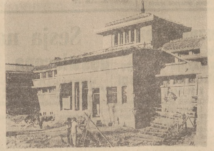
Na zdjęciu: Remont zniszczonego przez amerykańskich imperialistów budynku muzeum w Pheonia. Fot. — CAF
